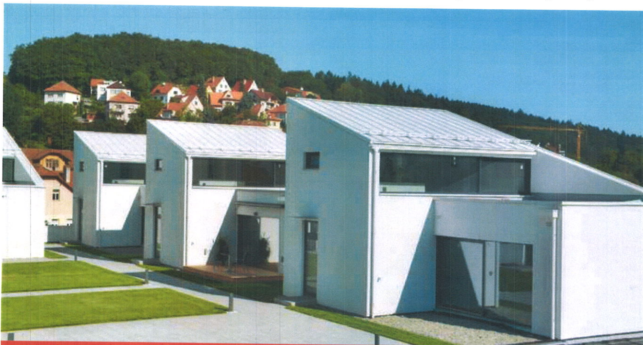
01 > Na střechě obchodního centra Alfa market v Luhačovicích už je dokončeno 12 apartmánů
