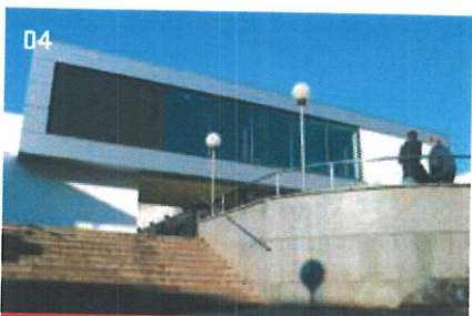
04 > Nové průčelí obchodního centra
